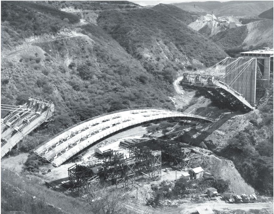
Figure I.3. Viaduct under construction on the Autopista Caracas–La Guaira, circa 1953. Archivo Histórico de Miraflores.
