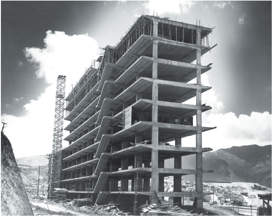
Figure I.2. Superbloque (superblock) under construction in Caracas. Anonymous, circa 1953. Archivo Histórico de Miraflores.
